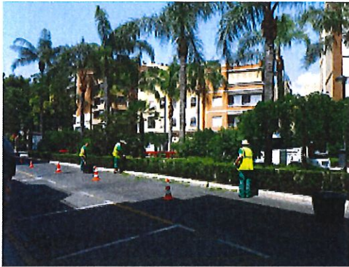
Retall de tanca vegetal en Av. Al Vedat
