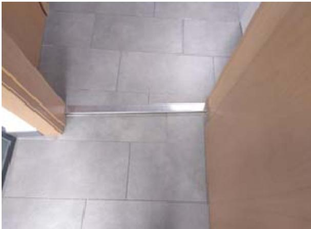
Se coloca un plano inclinado de chapa lagrimada para salvar el desnivel en el recorrido al aseo practicable en planta baja
